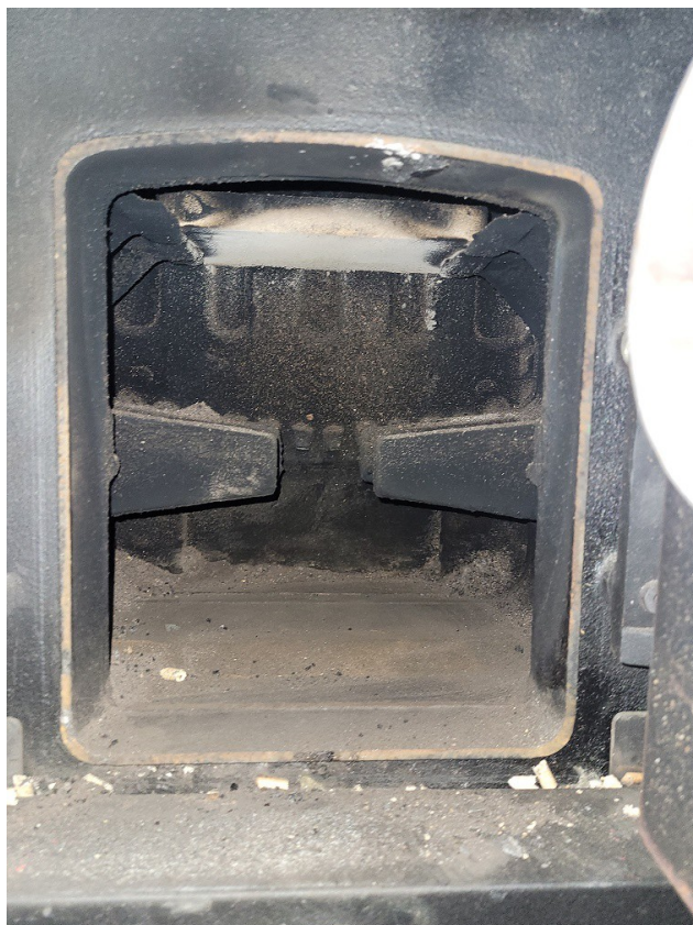
Rysunek 8 Komora spalania, popielnik
