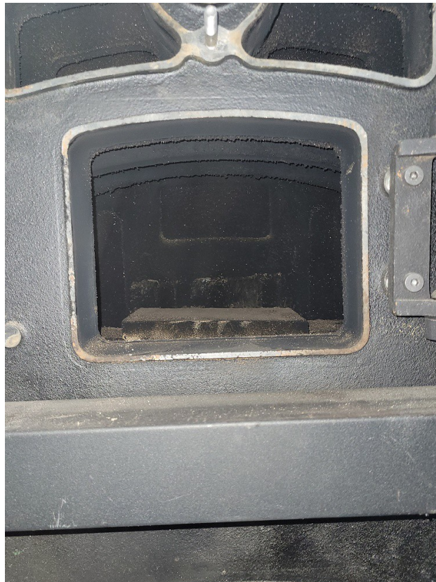
Rysunek 7 Górną komorą wymiennika
