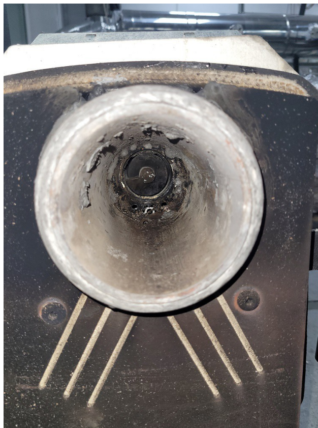
Rysunek 9 Palnik pelletowy
