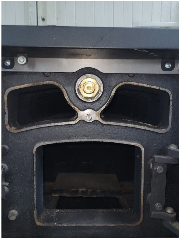
Rysunek 6 Górną komorą wymiennika
